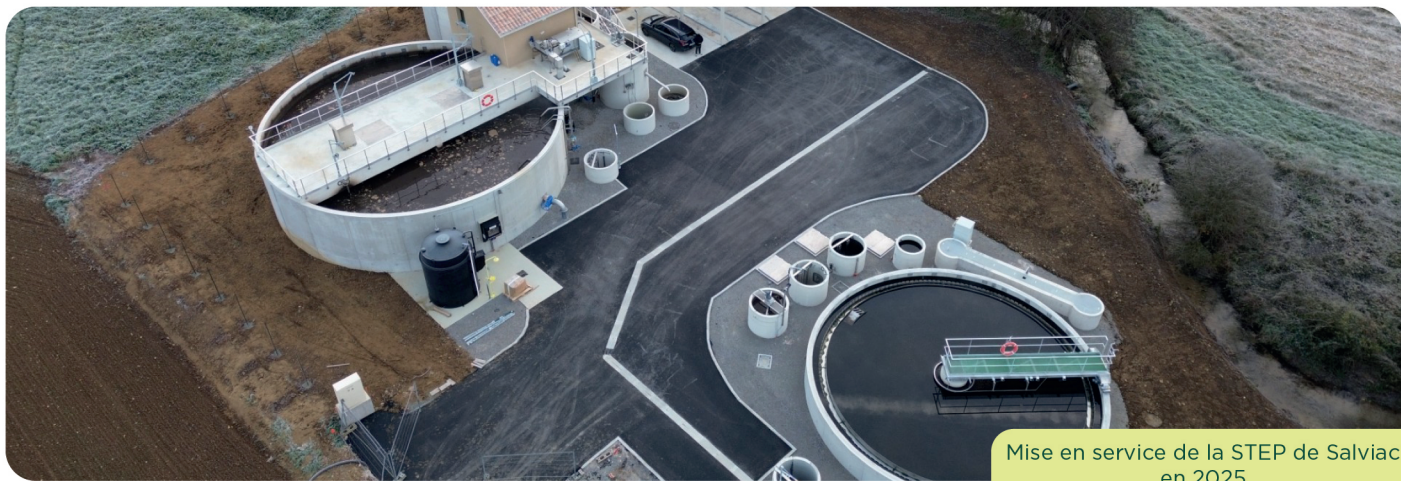
Travaux réalisés sur le service assainissement de Salviac
