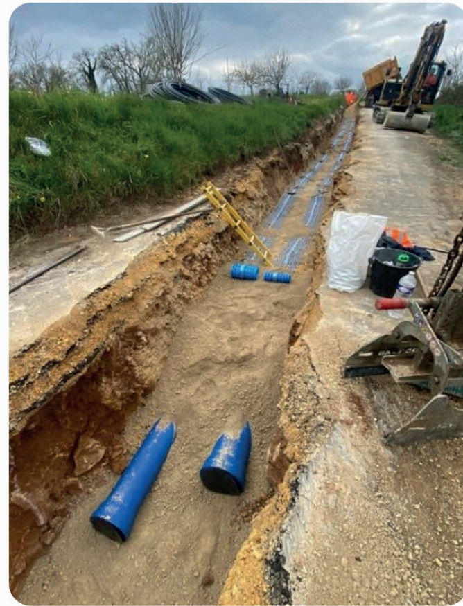
Chantier d'alimentation des réservoirs de Boutenègre
