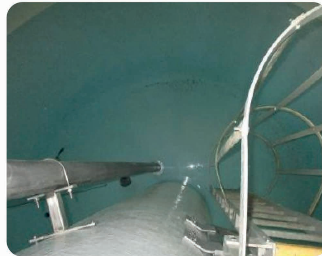
Réservoir de Miallet
